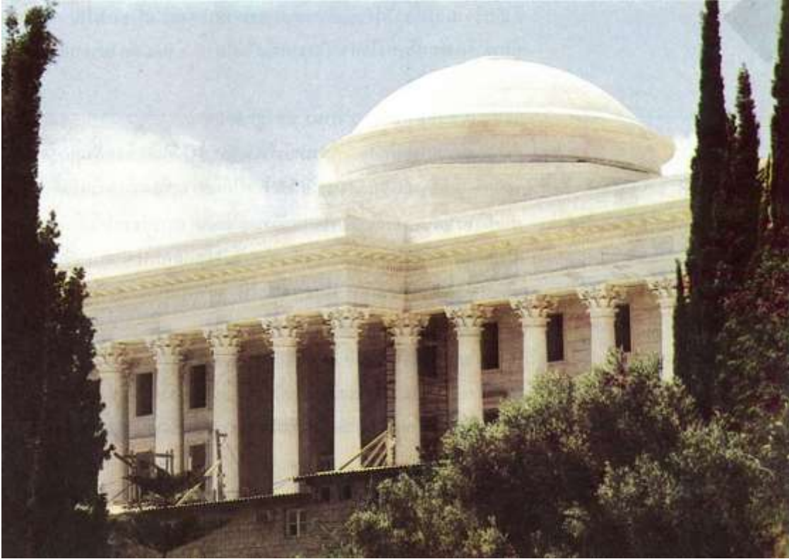
ที่ทำการของสภายุติธรรมแห่งสากล อยู่ที่ไหล่เขาคาเมล เมืองไฮฟา ประเทศอิสราเอล
